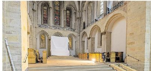
Blick in den Chorraum mit dem vor Baustaub geschützten Hochaltar
