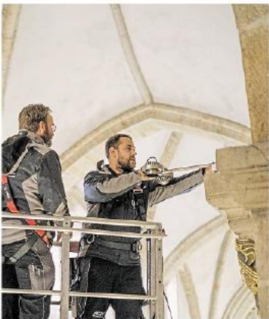
Die ersten Vorbereitungen für die neue Beleuchtung.
