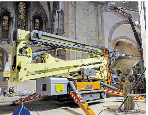
Hubsteiger und Handwerker sind eingezogen.
