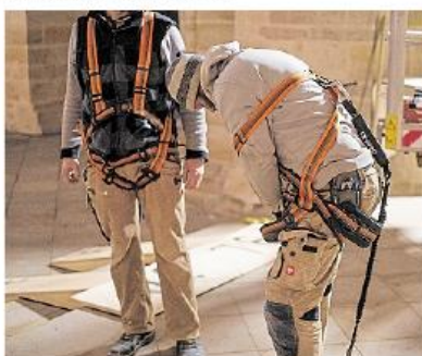
Die Handwerker müssen sich für den Höheneinsatz ordentlich sichern.
