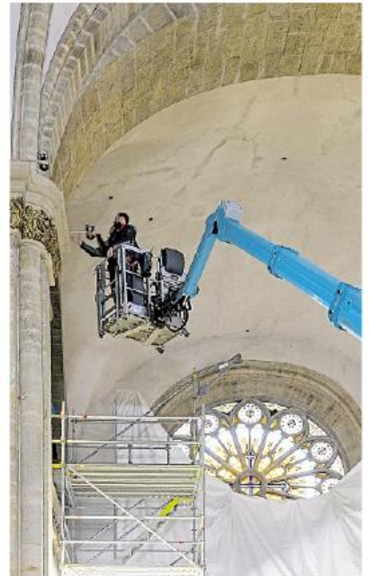
Höhenangst ist hier fehl am Platz: Die Handwerker arbeiten mit Hilfe eines Hubsteigers knapp unter der Decke des Doms.
